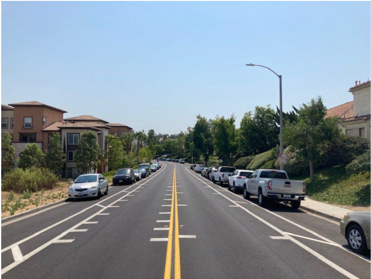
Fase I – Marcas de reducción de velocidad y franja separadora de carril de estacionamiento
