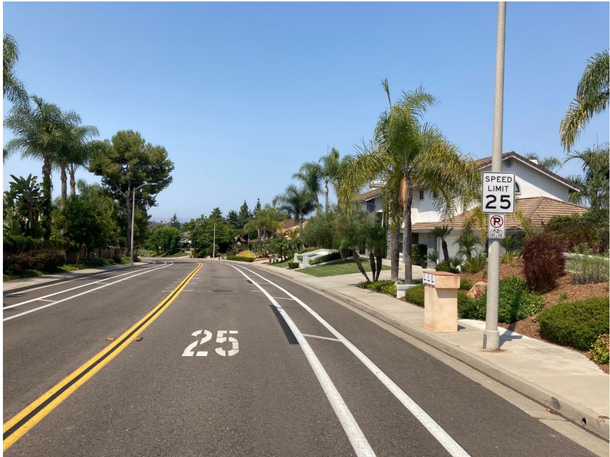
Fase I – Señal de límite de velocidad y marcado y estrechamiento de carriles
